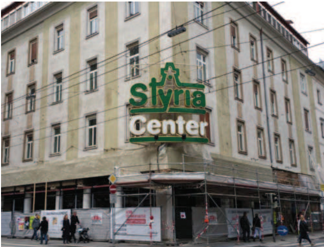
Anfang Oktober 2015 starteten die Umbauarbeiten.
